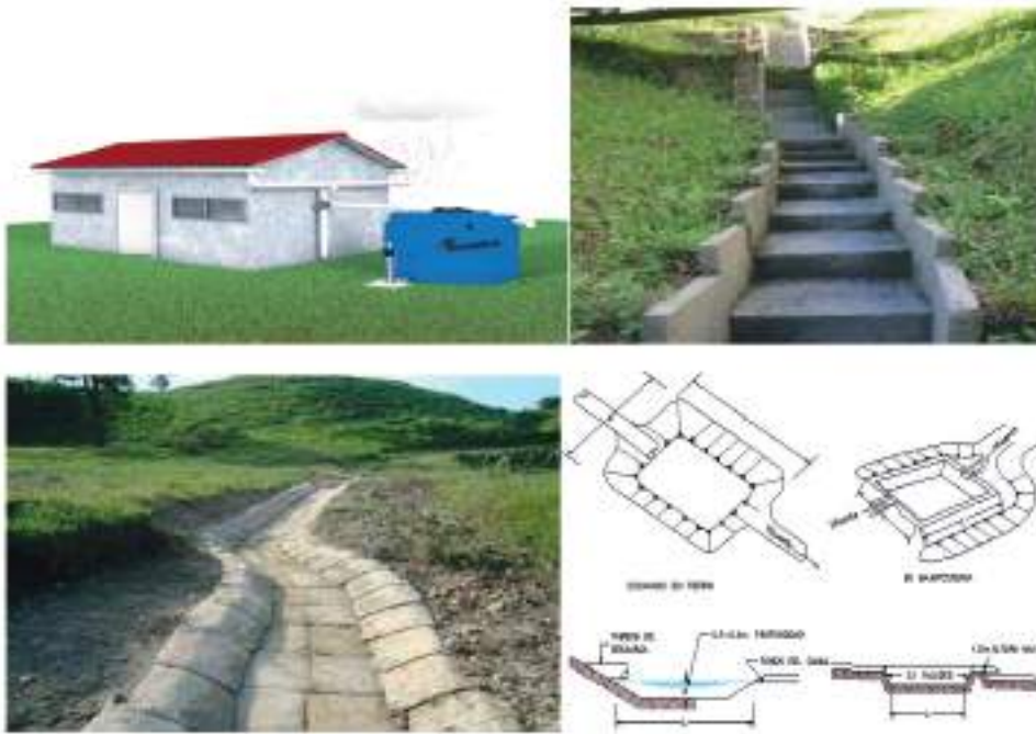
Figura 6.11. Medidas de manejo de aguas lluvias en campamentos (ilustración que no sugiere el tipo de campamento)
