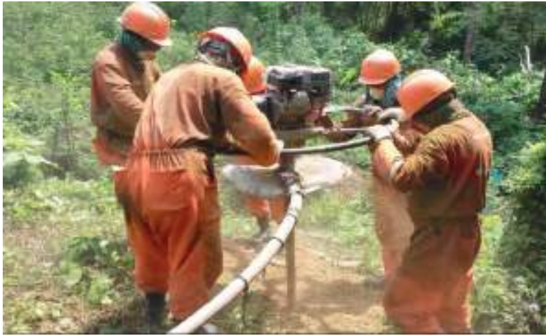
Figura 5.4. Perforación sísmica con taladros neumáticos
