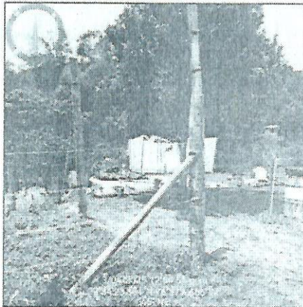
Fotografía 11. Construcción encerrada en malla y plancha.
