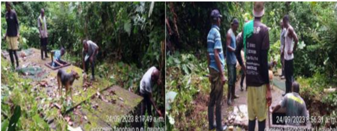
Figura 38. Evidencia Fotográfica Minga comunitario para el Mantenimiento y Reparación De Daños menores de la bocatoma del acueducto.
