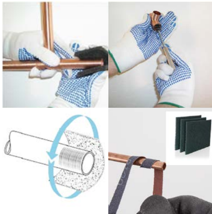
Figura 38 Limpieza del extremo de los tubos
