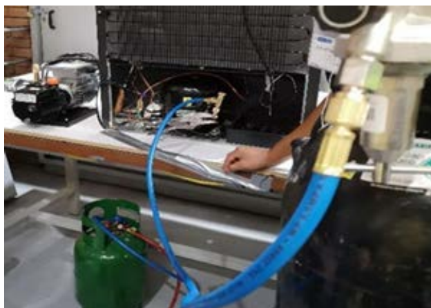
Figura 73 Uso de tanque auxiliar en prueba de hermeticidad
