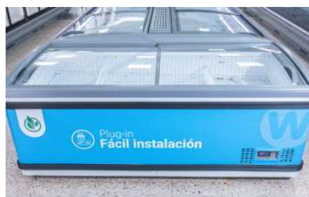
FOTO 1. SISTEMA AUTOCONTENIDO DE EXPANSIÓN DIRECTA (CONGELADOR HORIZONTAL)
