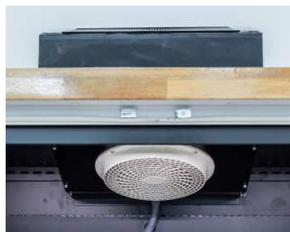
FOTO 7. CUARTO FRÍO PEQUEÑO CON SISTEMA MONOBLOCK
