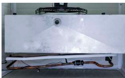
FOTO 118. EVAPORADOR ESCARCHADO
