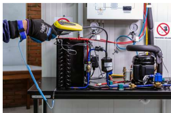
FOTO 115. MANTENIMIENTO PREVENTIVO PARA DETECCIÓN DE FUGAS
