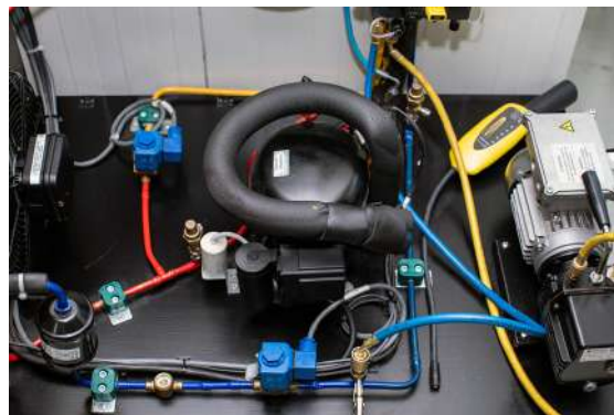
FOTO 130. INERTIZACIÓN CON NITRÓGENO
