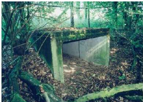
Figura 41: Box para fauna pequeña (ancho 1,2m, alto 0,8m, largo 40m.), en la carretera A50 en Holanda.
