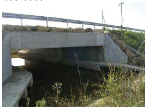
Figura 42: Box culvert con pasarelas a ambos lados.
