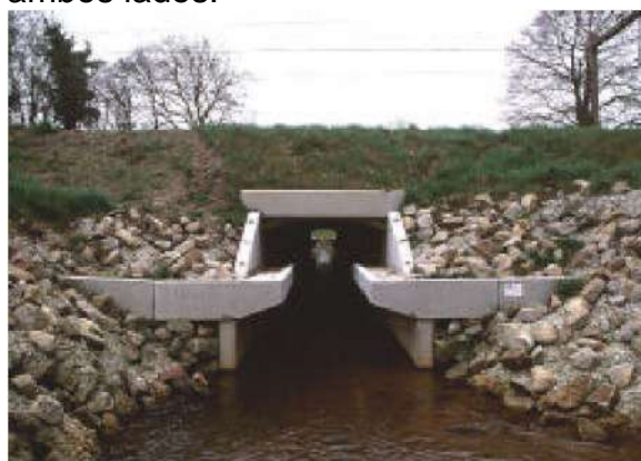
Figura 40: Box culvert con pasarelas a ambos lados.
