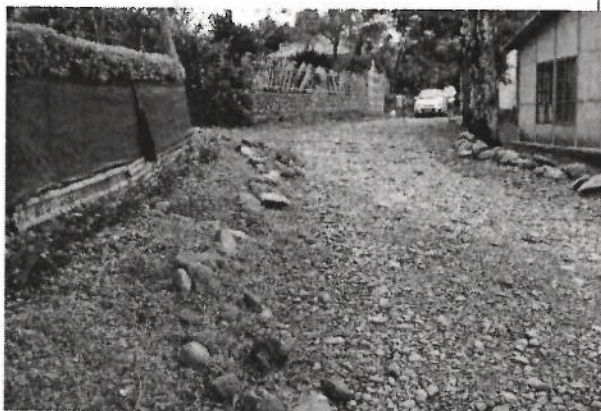
Fotografía 2. Vía existente posterior al cruce con el Caño Jabón, correspondiente a un tramo de vía a nivel, que hace parte del trazo del viaducto relacionado con la solicitud de sustracción.
