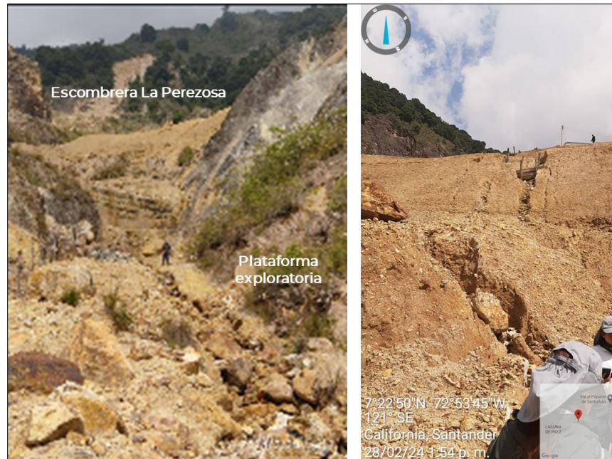
Figura 4545. Falla en escombrera y desarrollo de procesos erosivos en ZODME, Sector quebrada La Perezosa, Municipio de California – Departamento de Santander. La falla de estas estructuras genera una afectación al entorno. Fuente: ANLA, a partir de información del archivo de ANLA.
