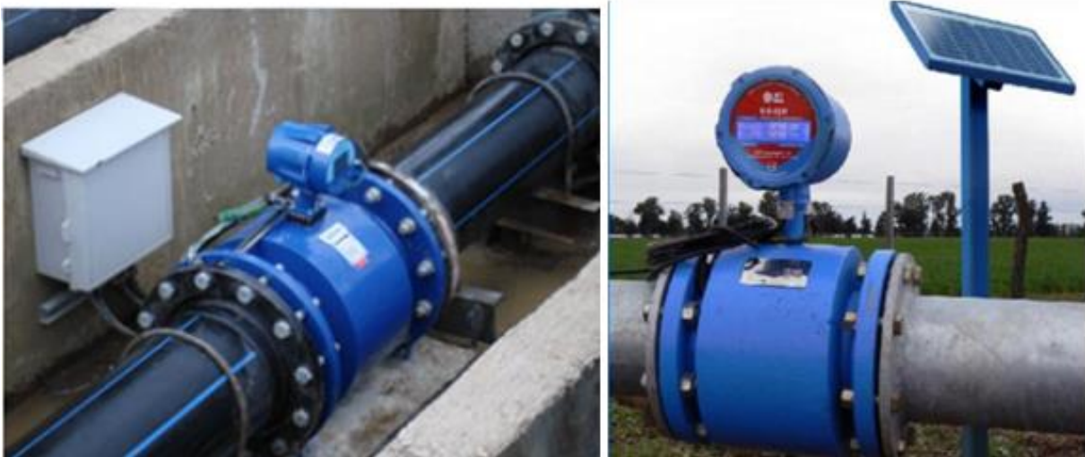
Figura 10. Medidor de Caudal electromagnético en tubería de impulsión de agua residual Fuente. Medidores de Caudal de Aguas Residuales. SEDAPAL, 2016.
