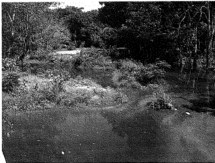
Unión entre la quebrada Lejía y quebrada La Mula (Metros antes de la construcción de la bocatoma)
