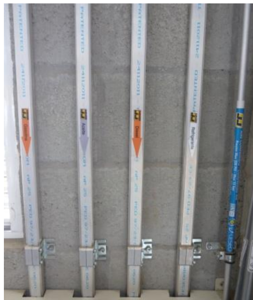
Tubería para el transporte de los fluidos peligrosos obtenidos de un vehículo a desintegrar desde el equipo de extracción hasta el sitio de almacenamiento temporal
