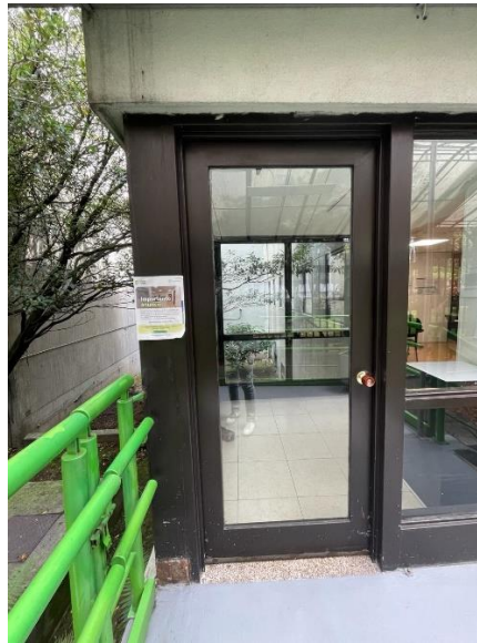
Ilustración 1. Puerta acceso Servicio a la ciudadanía, vista exterior
