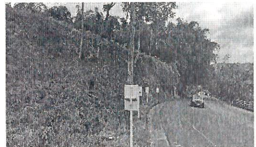
zona de ampliación coordenadas: X = 4705492.89 - Y = 2059898.215 Rumbo: S 25° O
