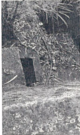
Alcantarilla coordenadas: X 4705879,68 - Y 2060165,89 Rumbo: N 65° O
