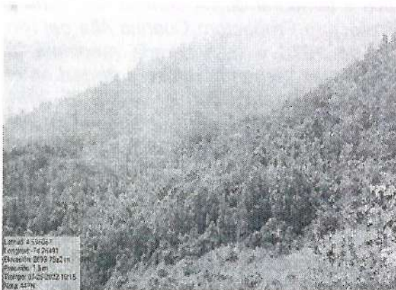
Figura 3.3. Inicio del recorrido. Vista a la torre 447N con coordenadas X: 4.596067 Y: 74.284491, Elevación msnm: 2693.
