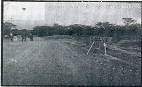
Foto 1. Estado actual del acceso terrestre visitado, donde se observa el punto final de la placa huella 2 con actividades constructivas
