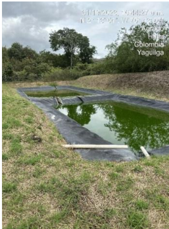
Fotografía: CGR Oct 31 2023, Piscinas del sistema de tratamiento PTAR del reasentamiento San José de Belén
