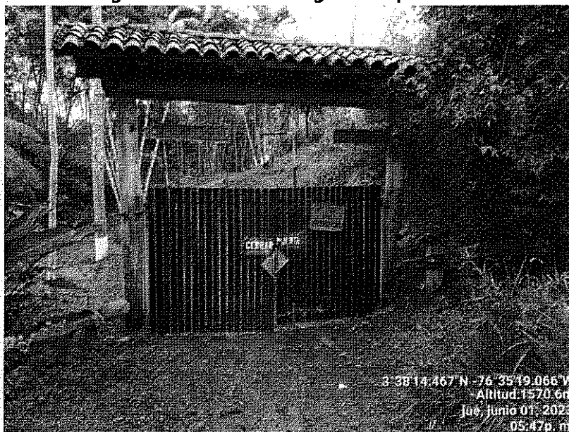
Fotografía 2. Puerta de ingreso al predio.
