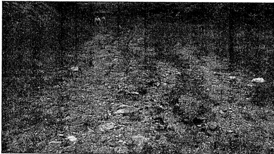
Fotografía 5 Erosión en surcos vías de acceso interno.
