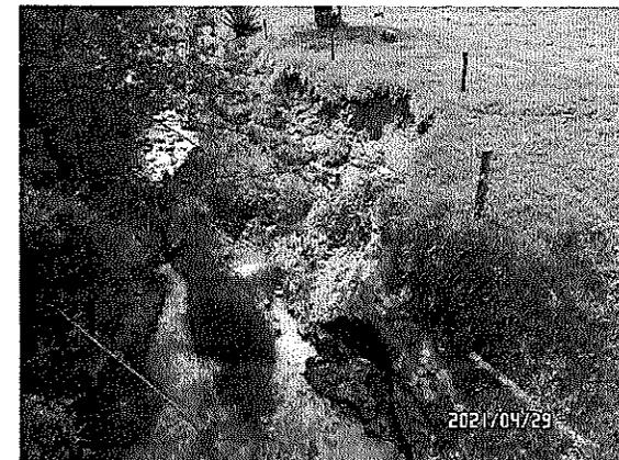
Foto 11. Proceso de socavación del río Checua a la altura del Puente Checua.
