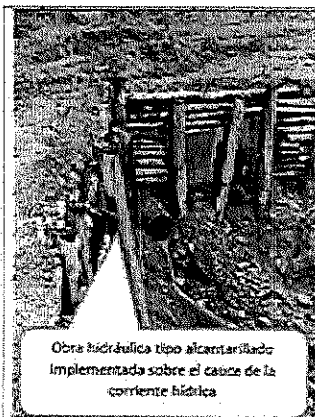
Foto 9. Obra hidráulica tipo alcantarilla ocupando cauce de la quebrada.
