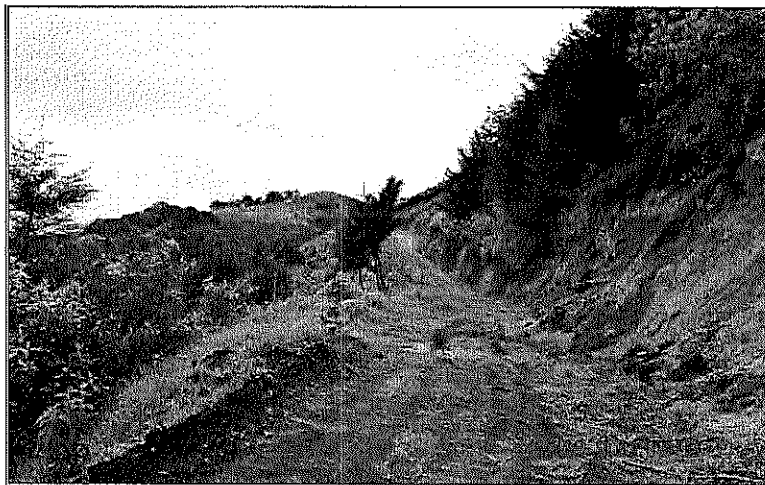
Fotografía 13. Recorrido de la vía interna aperturada para acceder al lote 5 en el predio Monteloro.
