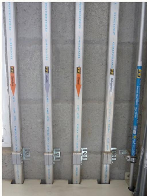
Tubería para el transporte de los fluidos peligrosos obtenidos de un vehículo a desintegrar desde el equipo de extracción hasta el sitio de almacenamiento temporal.
