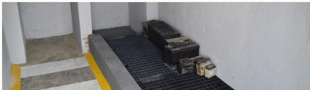
Disposición adecuada de baterías plomo-ácido usadas sobre bandejas con sistemas de retención de escurrimientos.
