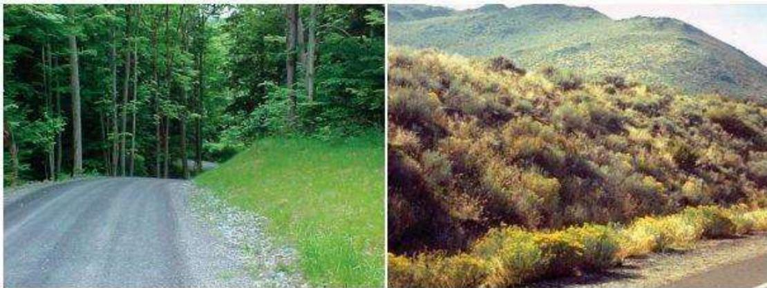
Fotografía 4 Taludes estabilizados con vegetación.
