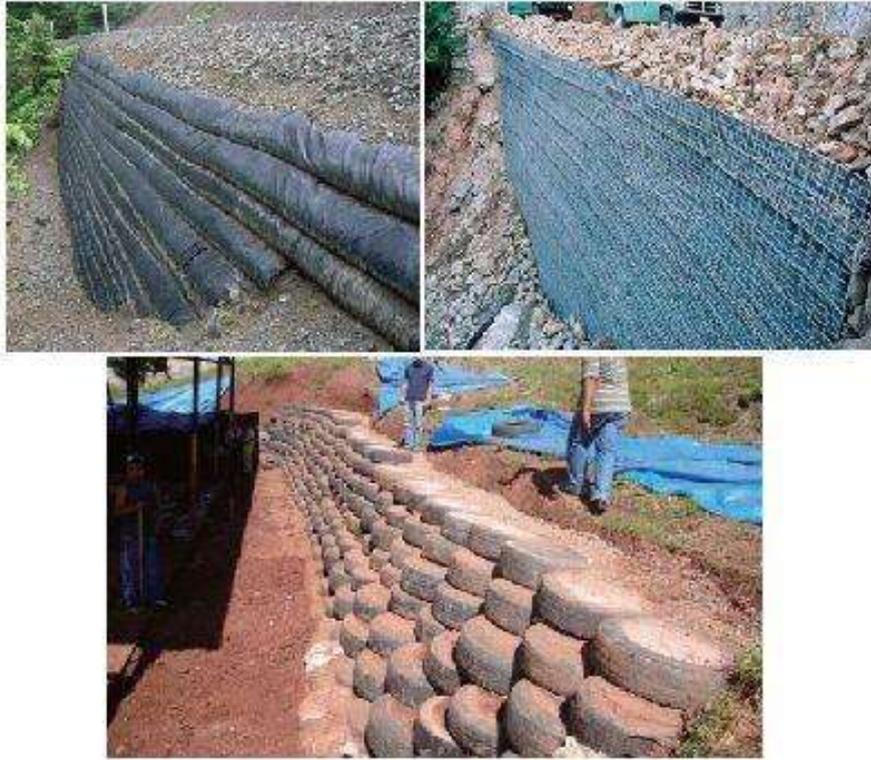
Fotografía 3 Muros de contención con diversos materiales.
