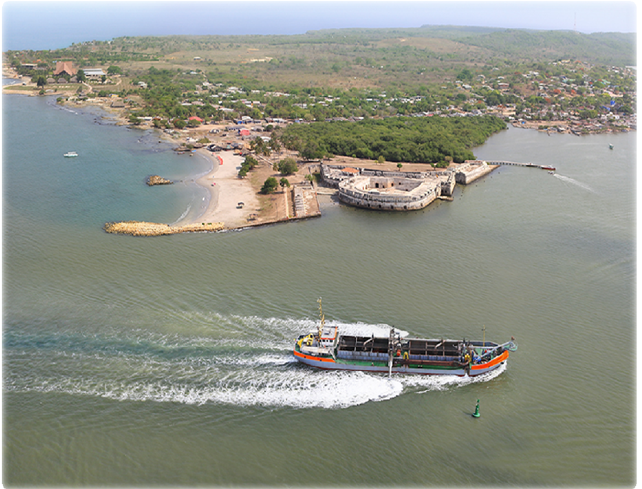
Foto 5: Cartagena. Fuente: Dragados Hidráulicos
