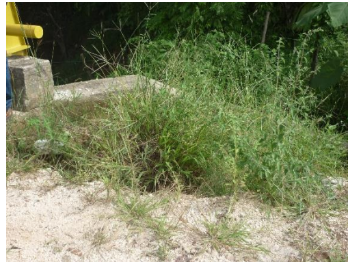
Socavación de material en aleta.
