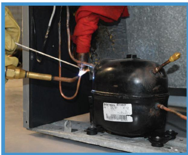
Figura 52. Instalación filtro secador nuevo.
