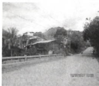
Fotografía No. 2 Vía existente
