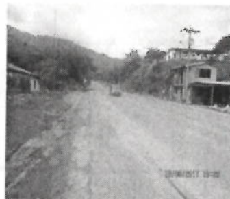
Fotografía No. 3. Tejido urbano discontinuo
