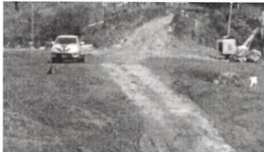
Fotografía No. 8 – Carreteable actual dentro del área solicitada en sustracción
