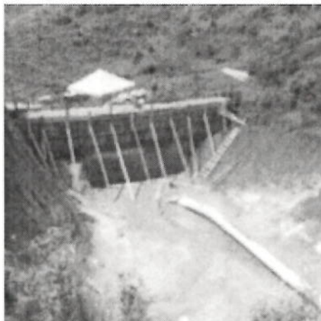
Construcción de relavera
