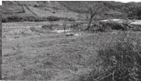
Fotografía 2. Localización casa de máquinas
