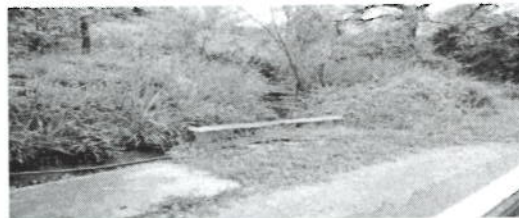
Alcantarilla sobre la vía por donde atraviesan las aguas del drenaje.
