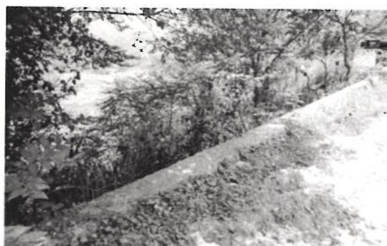
Alcantarilla sobre la vía por donde atraviesan las aguas del drenaje.
