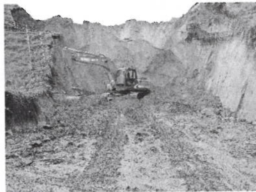
Fotografía 6. Excavación apertura de vía
