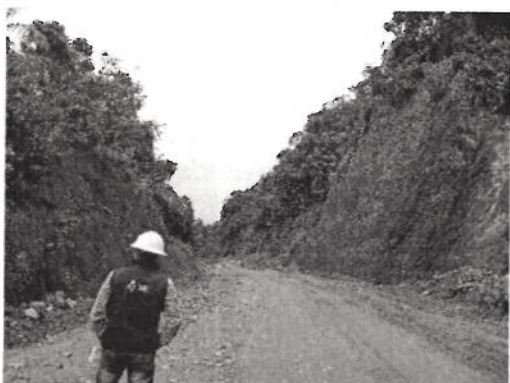
Fotografía 7. Vía existente, polígono 3
