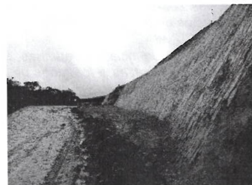
Fotografía 5. Taludes al margen de la vía existente
