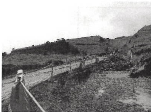
Fotografía 7. Excavación sobre la vía existente
