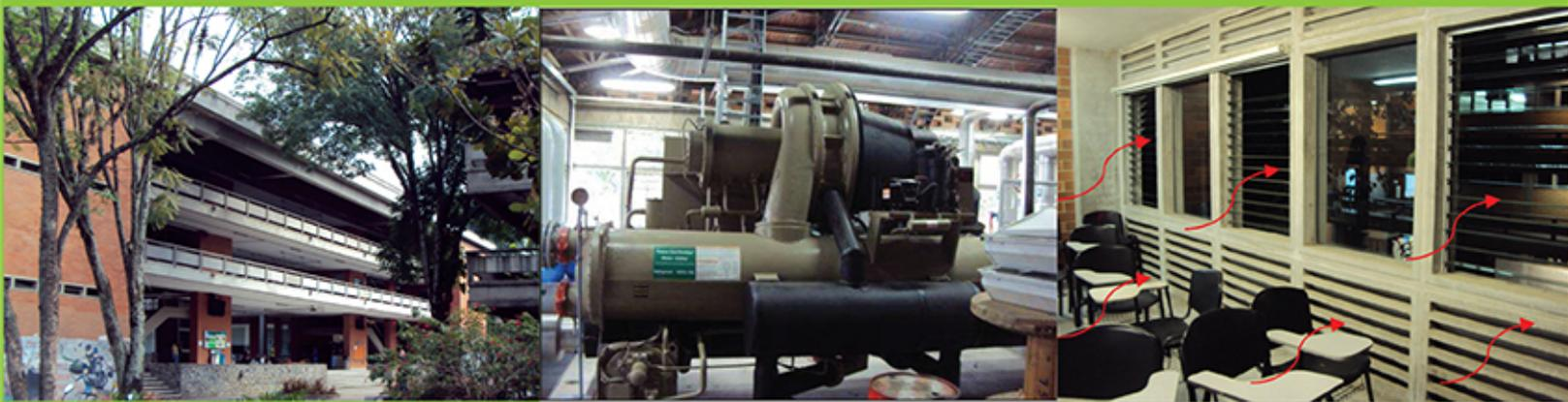
El sistema de distribución de agua dispone de tres bombas primarias, posteriormente en el circuito secundario comprende dos bombas de 100 HP, donde una se encuentra a modo de reserva. Las bombas del anillo secundario poseen un variador de velocidad con el fin de adecuar el caudal de impulsión a las necesidades específicas de los bloques conectados al circuito de distribución de agua fría.
