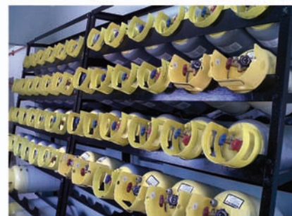
Fotografía 1: Almacenamiento de cilindros retornables, Centro de Regeneración SENA - Colombo - Alemán - Bogotá
