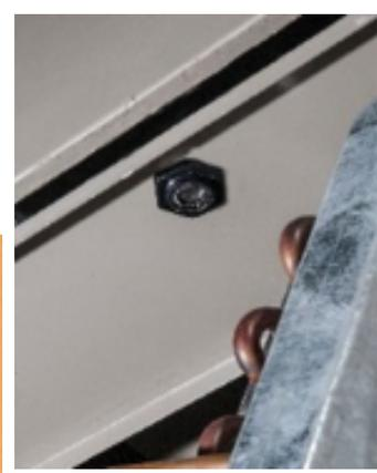
**Figura 8.** Sensor ultrasonido.
