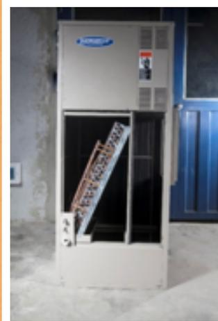
**Figura 7.** Estructura, mueble o armazón de la unidad manejadora.
