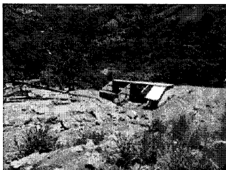
Fotografía No 1. Deslizamiento del Coluvión
