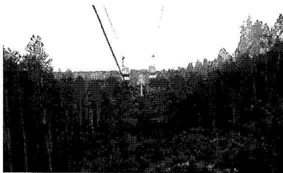
2. Se observa ciertas áreas sin cobertura vegetal, al realizar el recorrido en sitio (debajo de la línea del Metrocable), se establece que no son procesos erosivos naturales, sino el proceso de apisonamiento que experimenta el área por la vigilancia del derecho de vía del Metrocable (sendero de cruce de caballos).
