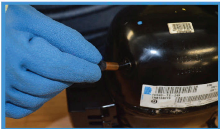
Figura 40. Tapones en los tubos del compresor
