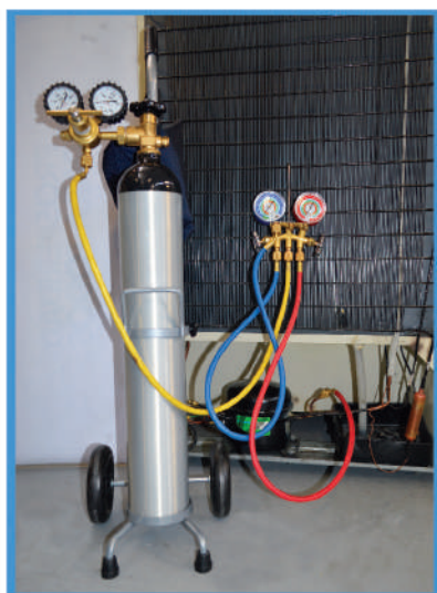
Figura 56. Carga del sistema con nitrógeno.
