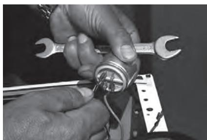
**Ilustración 75:** Sacar los cables del condensador.
