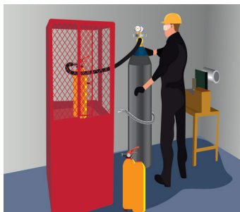
Figura 45. Proceso de presurización con nitrógeno
