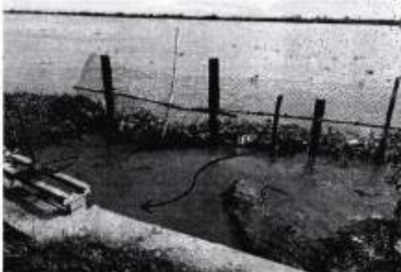
Obras captación río Magdalena Fuente: CGR, 2019
