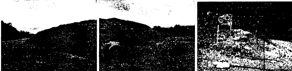
FIGURA No. 5. Botaderos de colas, sin perfilamiento-mantenimiento.
