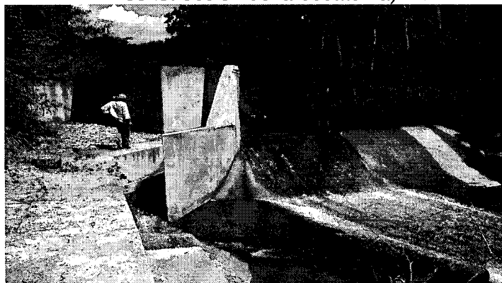
Construcción de la bocatoma.
