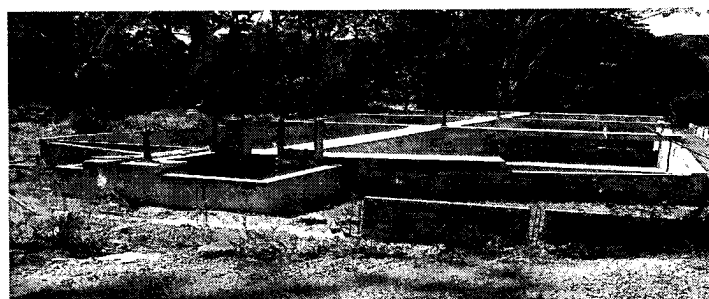
Construcción del desarenador.
