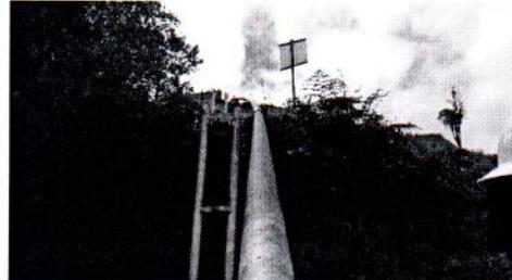
*No obstante lo anterior, en la zona se ha presentado otros procesos de remoción en masa que han afectado el poliducto, ver fotografía No. 8a, donde la empresa ha adelantado actividades de protección del tubo, la construcción de trinchos, muro de contención y concreto lanzado.*
