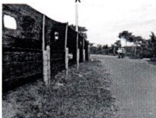
Fotografía 29. Área nueva línea de flujo plataforma AB 3 – Subestación.
