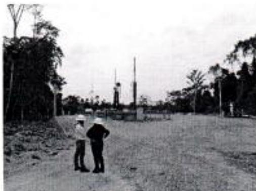
Fotografía 32. Plataforma AB 5 existente.
