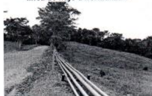
Fotografía 39. Línea de flujo existente.
