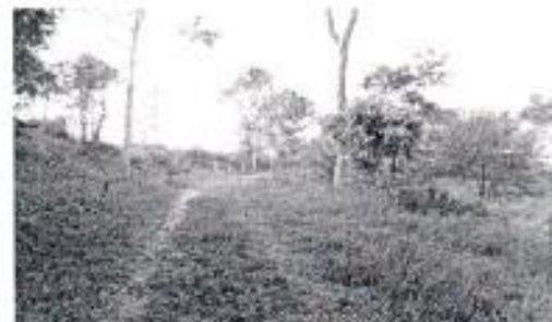
Fotografía 25. Vía nueva a la bocatoma 2
