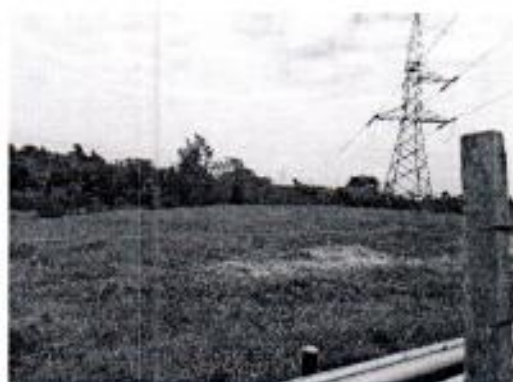
Fotografía 14. Área ampliación subestación.
