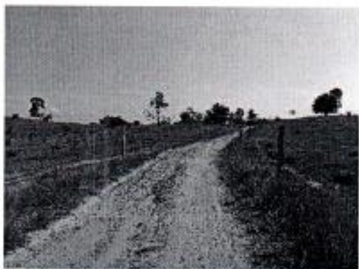
Fotografía 26. Vía de acceso a Plataforma AB A
