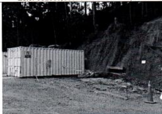
Sector Subestación RCN – Cambio de uso del suelo previo – Coordenada Este: 830083,6289 / Norte 991347,3832
