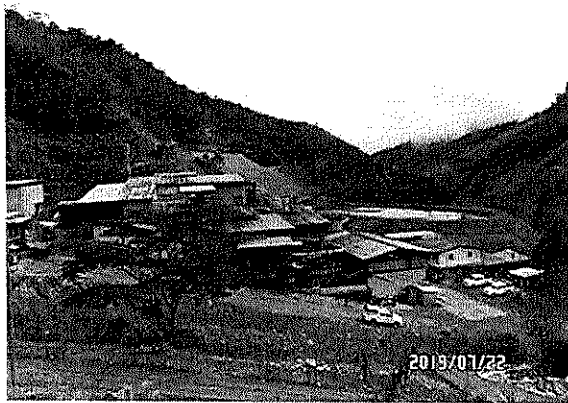
Figura 17. Vista general oficina inferior, presa 1, auxiliar y pozo de contingencia
