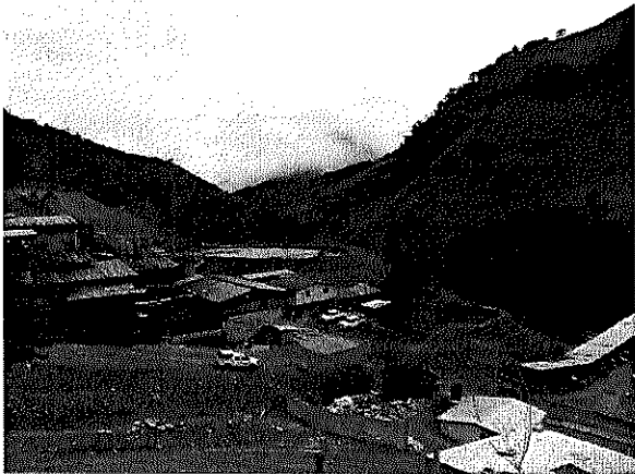
Figura 25. Vista paisaje de montaña en el área solicitada en sustracción definitiva
