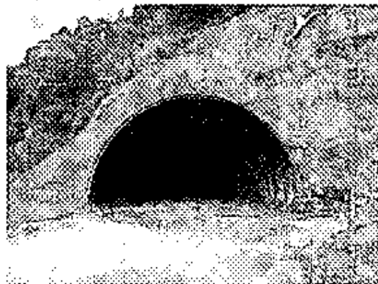
Portal de entrada Túnel Bermellón.
