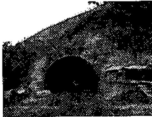
Portal túnel Baloncito.
