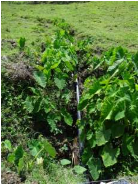
Fotografía E. Drenaje canalizado y toma de agua para uso humano.
