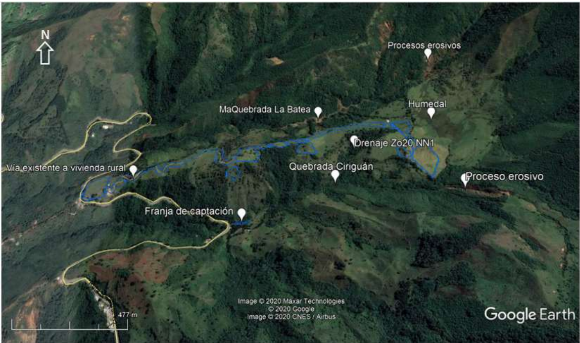
Figura 9. Panorámica de los polígonos que conforman la ZODME 20.
