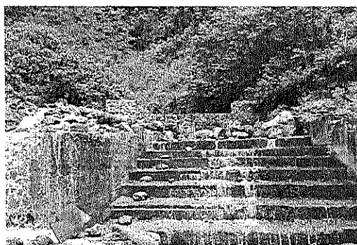
Fotografía 12. Jarillón y disipador de energía
