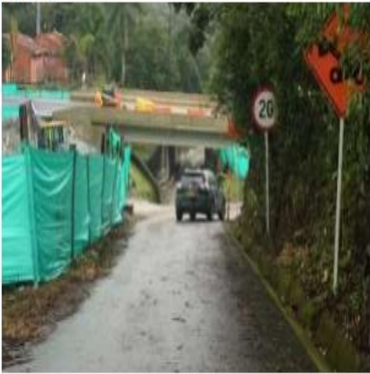
Figura 7. Via que se proyecta adecuar, vista hacia la doble calzada Bogotá-Villavicencio. Sector donde se proyecta el manejo de la pendiente.
