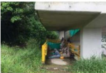
Figura 9. Costado sur del puente peatonal donde se proyecta la adecuación de terreno para acceso a la rampa.
