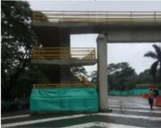
Figura 11. Vista frontal costado norte del puente peatonal, se evidencia la rampa construida
